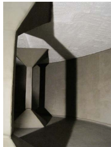
Fertige Beschichtung im Behälter (Decke, Sohle, Wände und Stützen)
