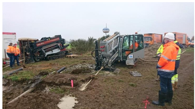
HDD Bohrung unterhalb der Autobahn A1
