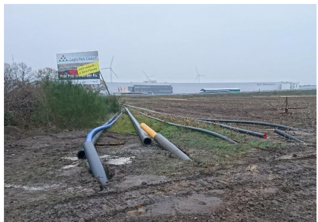
Zielgrube der HDD Bohrung, südlich der Autobahn A1
