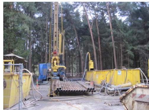
Fortsetzung des Überbohrens ab -65 m u.GOK im Lufthebebohrverfahren
