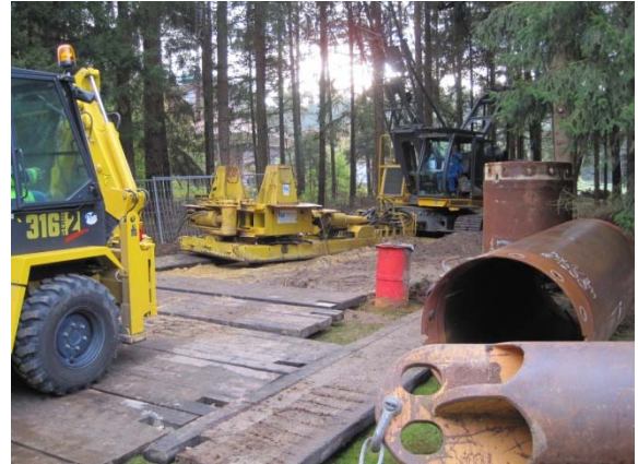
Standrohre und Drehtisch zum Überbohren des alten OBO-Brunnen
