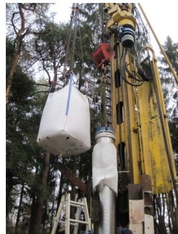
Doppelte Kiesschüttung mit Schüttkörben beim Einbau
