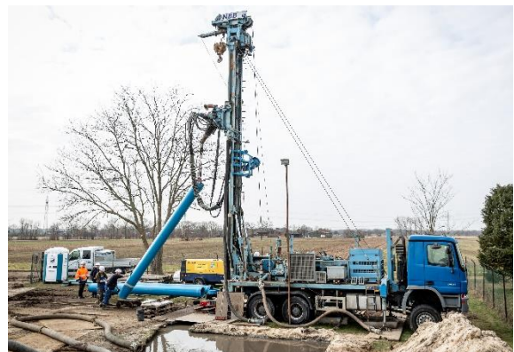
Einbau der PVC-Aufsatzrohre (DN 400)
