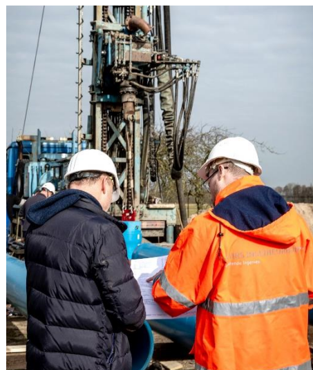
Bauüberwachung und Terminplankoordinierung
