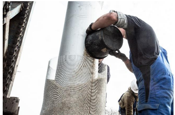
Einbau Wickeldrahtfilter inkl. Befüllung der Kieskörbe zur Herstellung der inneren Kiesschüttung (Filterkies Ø 3,15 – 5,6 mm)
