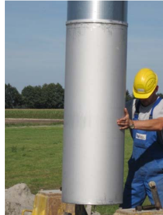
Filterrohr (Edelstahl 1.4571) mit Sumpfrohr
