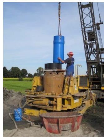
Bohrgerät (Drehtisch + Seilbagger) mit Standrohr und Einbau Brunnenmaterial
