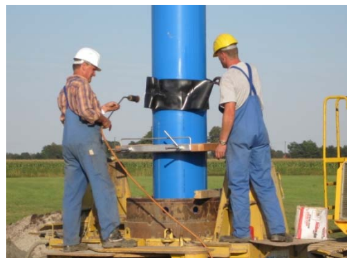
Dichtung PVC-Aufsatzrohr mit Schrumpfmanschette
