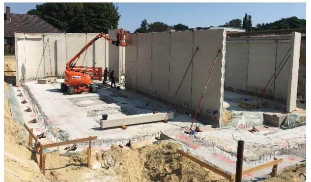
Aufstellen der Fertigteilwandelemente
