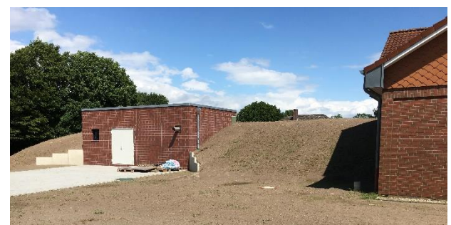
Ansicht Schieberkammer neben dem Bestandsgebäude
