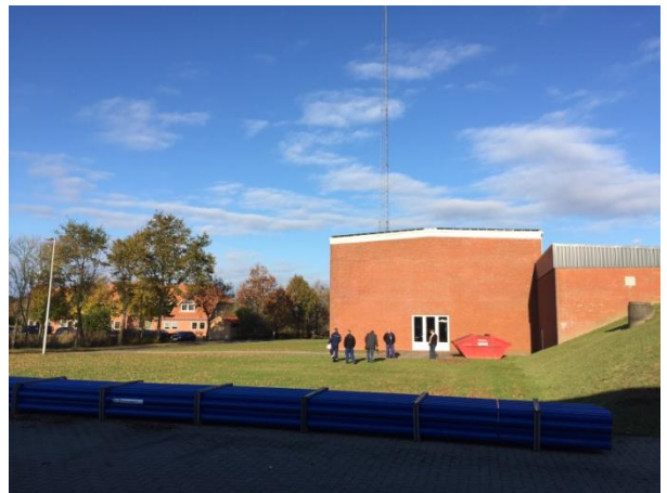
Baufeld für Neubau
