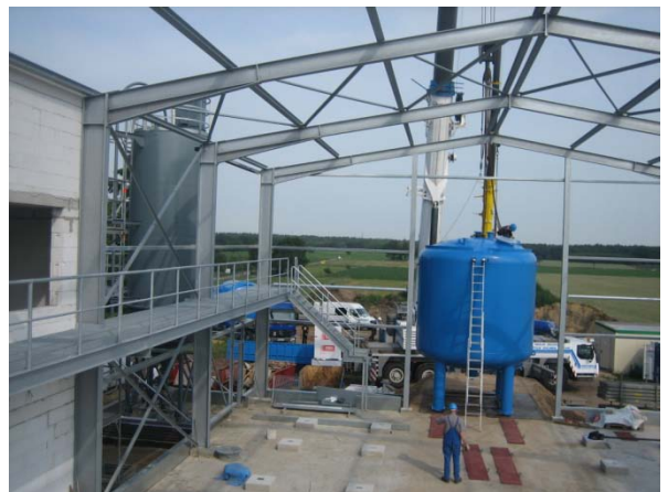
Stahlskelettbau Filterhalle
