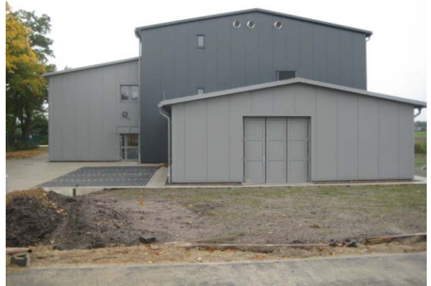
Giebelansicht: Pumpenanlage (vorne) / Filterhalle / Betriebsräume (links)
