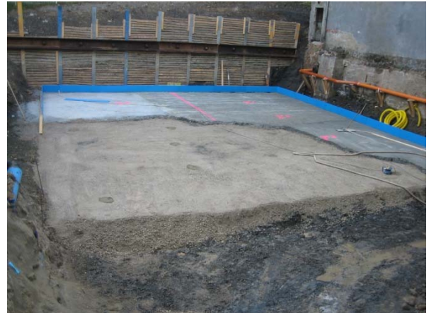
Unterbeton auf Tragschicht und Felsen / Spundwand zur Hangsicherung (Neubau zwischen Bestandsbauwerken!)
