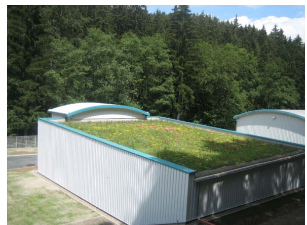
Neubau Behälter nach Abriss Bestand
