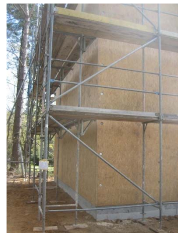
Holzbauhalle (im Bau)
