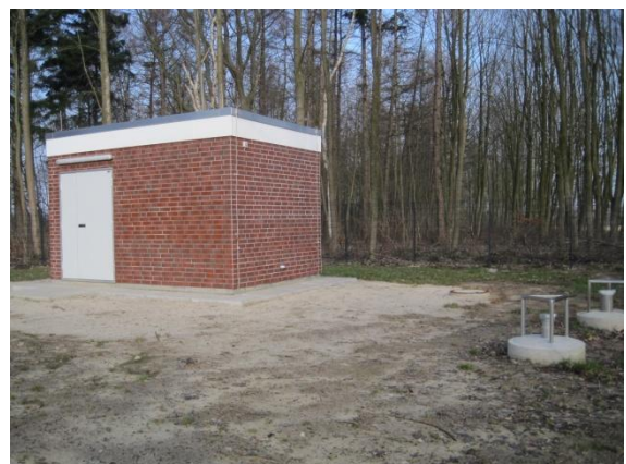
Brunnenstation mit 2 GWM für Beweissicherung der Absenkung usw. (Gelände ist eingezäunt)
