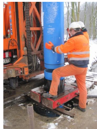
Einbau PVC-Aufsatzrohre DN 400 (Zweischicht-Betrieb)
