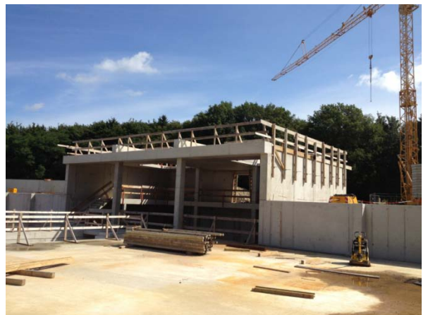
Rohbau Reinwassergebäude (vorn: Standort RW-Beh.)
