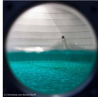
Blick in einen Edelstahl-Trinkwasserbehälter
