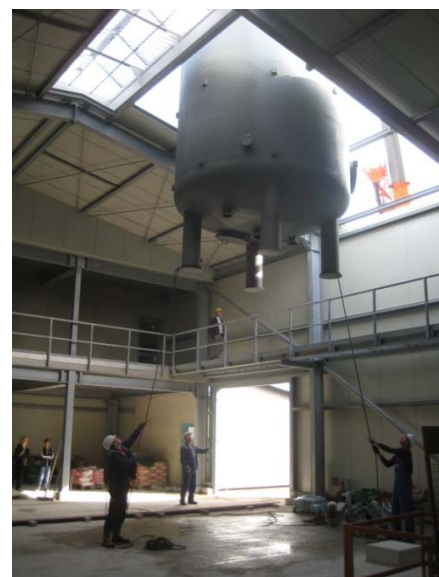
Einbringen der Filterkessel
