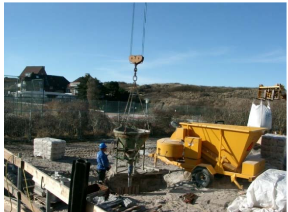
WU-Betonherstellung in Mischungsanlage vor Ort
