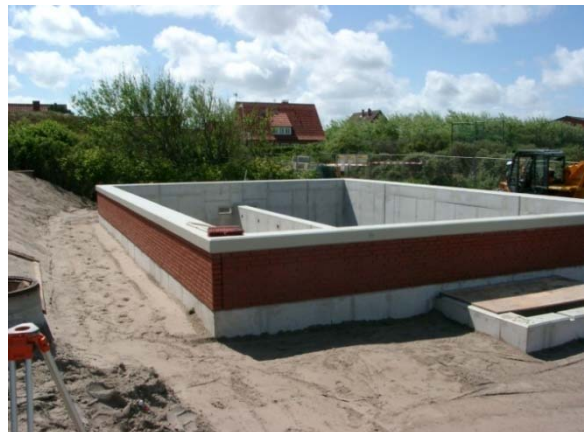
Absetzbecken mit Verblendmauerwerk
