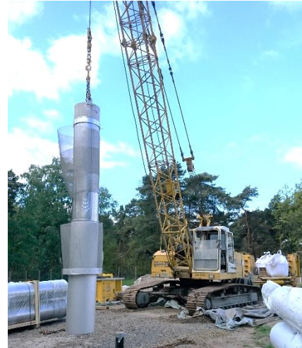
Einbau des Filterrohrstranges DN 500 (Edelstahl) mit eingeschweißtem Boden
