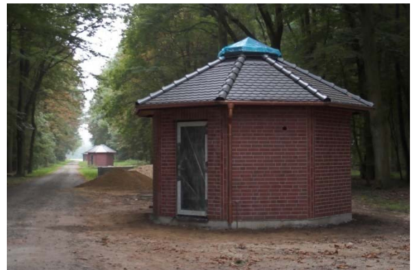
Brunnenstationen mit Lichtkuppel (für Pumpentausch)
