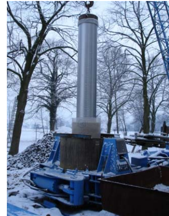
Bohrgerät (Drehtisch) mit Standrohr, Einbau Filterrohr mit Kieskörben
