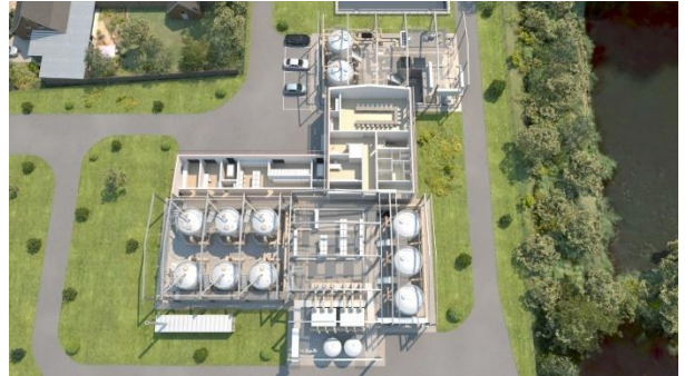
Visualisierung der Planung Neubau WW Dörenthe Vorne: Grundwasseraufbereitungsanlage (GW-WAA) Mitte: Betriebsräume Oben: DEK Oberflächenwasser-WAA
