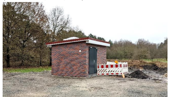
Fertigstellung und Inbetriebnahme der neuen oberirdischen Brunnenstation inkl. technischer Ausrüstung
