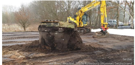
Rückbau Br. VII, Freilegung des alten Betonschachtes
