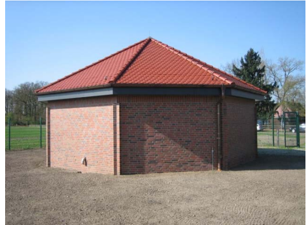
Außenansicht nach der Fertigstellung
