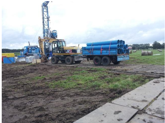
Erschwerte Baustellenzufahrt für Geräte und Material
