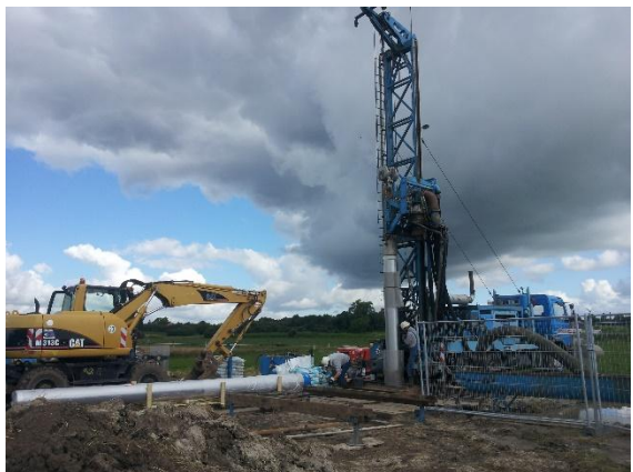
Einbau Filterrohr (Edelstahl-Wickeldrahtfilter DN 400)
