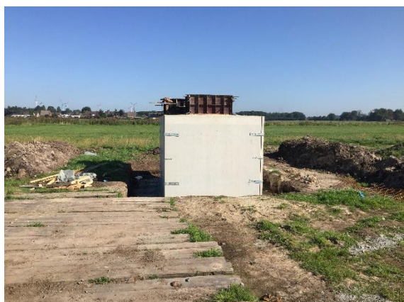
Brunnenschacht aus Betonfertigteilen, spätere Bodenüberdeckung und flach geneigter Böschung
