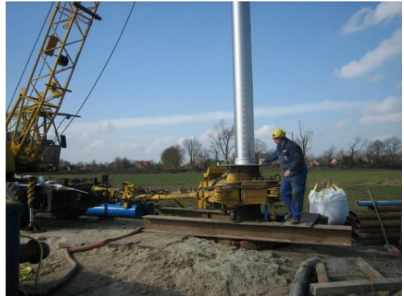
Bohrgerät (Drehtisch) mit Standrohr
